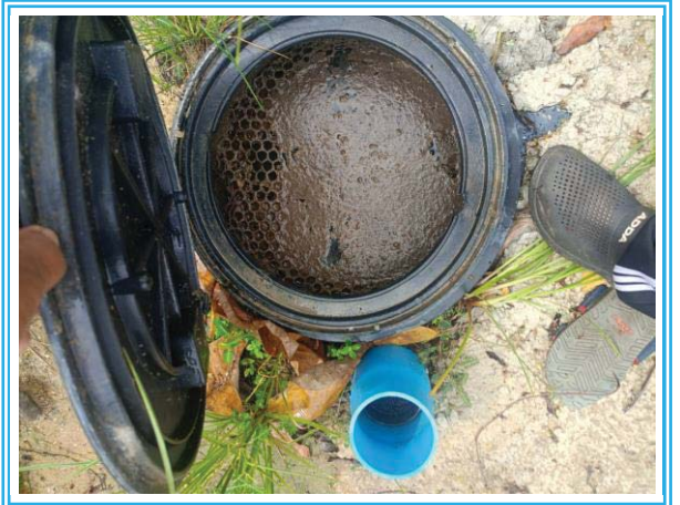
รูปที่ 3-16 ระบบบำบัดน้ำเสียชนิดเกราะ-กรองไร้อากาศ
