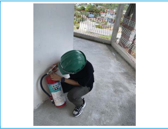
รูปที่ 3-51 ติดตั้งและตรวจเช็คถังดับเพลิง
