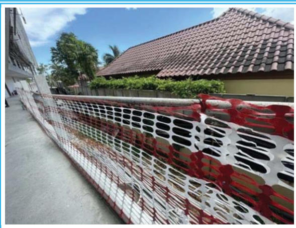
รูปที่ 3-53 ติดตั้งแนวรั้วหรือการปิดกั้นพื้นที่อันตราย
