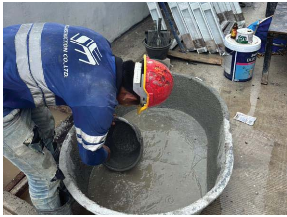
รูปที่ 3-19 กระบะสำหรับล้างวัสดุก่อสร้าง
