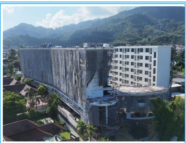
รูปที่ 3-3 ผ้าใบทึบ (Mesh Sheet) รอบอาคาร
